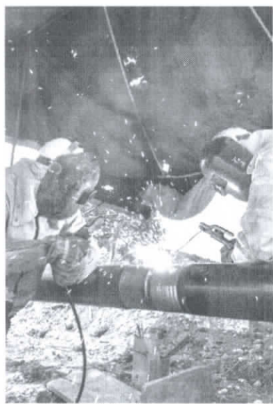
Construção do gasoduto Penedo-Arapiraca tem gerado empregos
