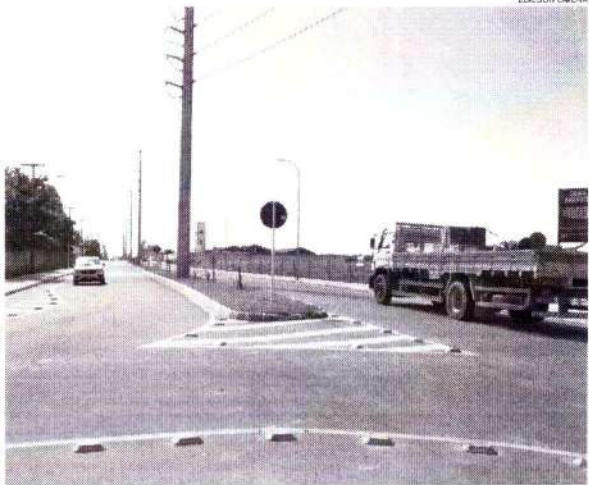
Obra faz parte do Programa Nova Maceió, tem duas faixas, com calçada, ciclofaixa e iluminação em led
