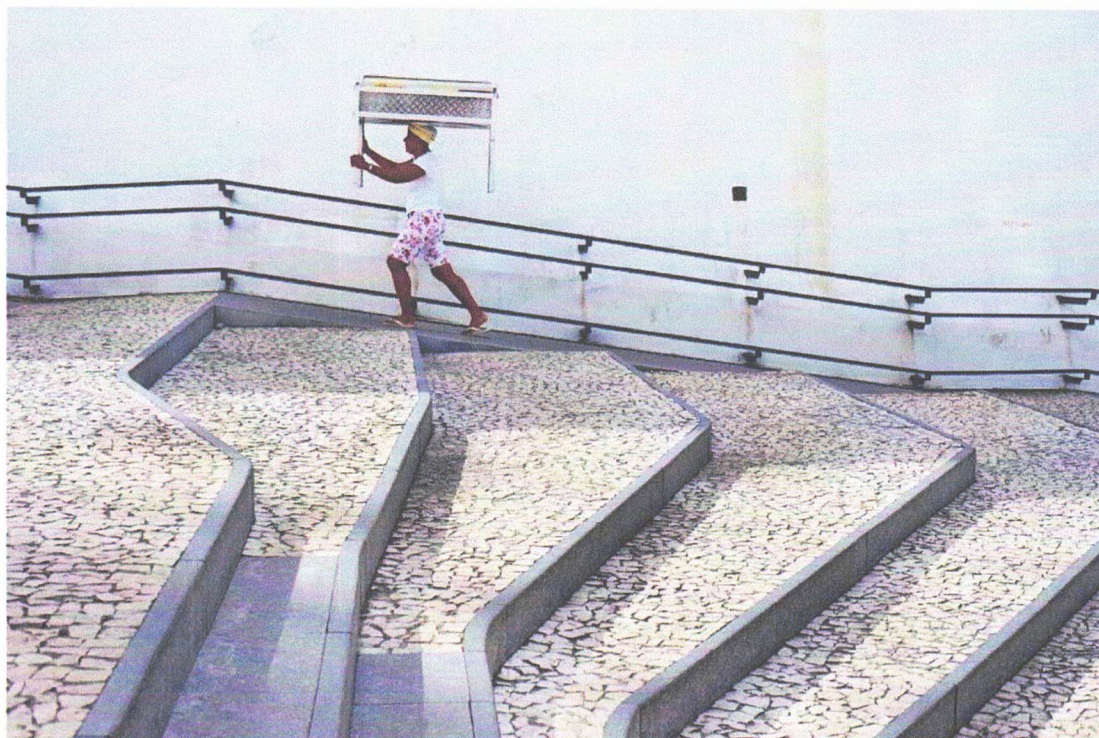
Figura 6-24: Combinação de rampa e escadaria para vencer vias íngremes – Salvador/BA
