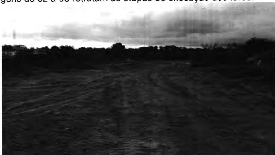
Figura 02 - Local de execução
