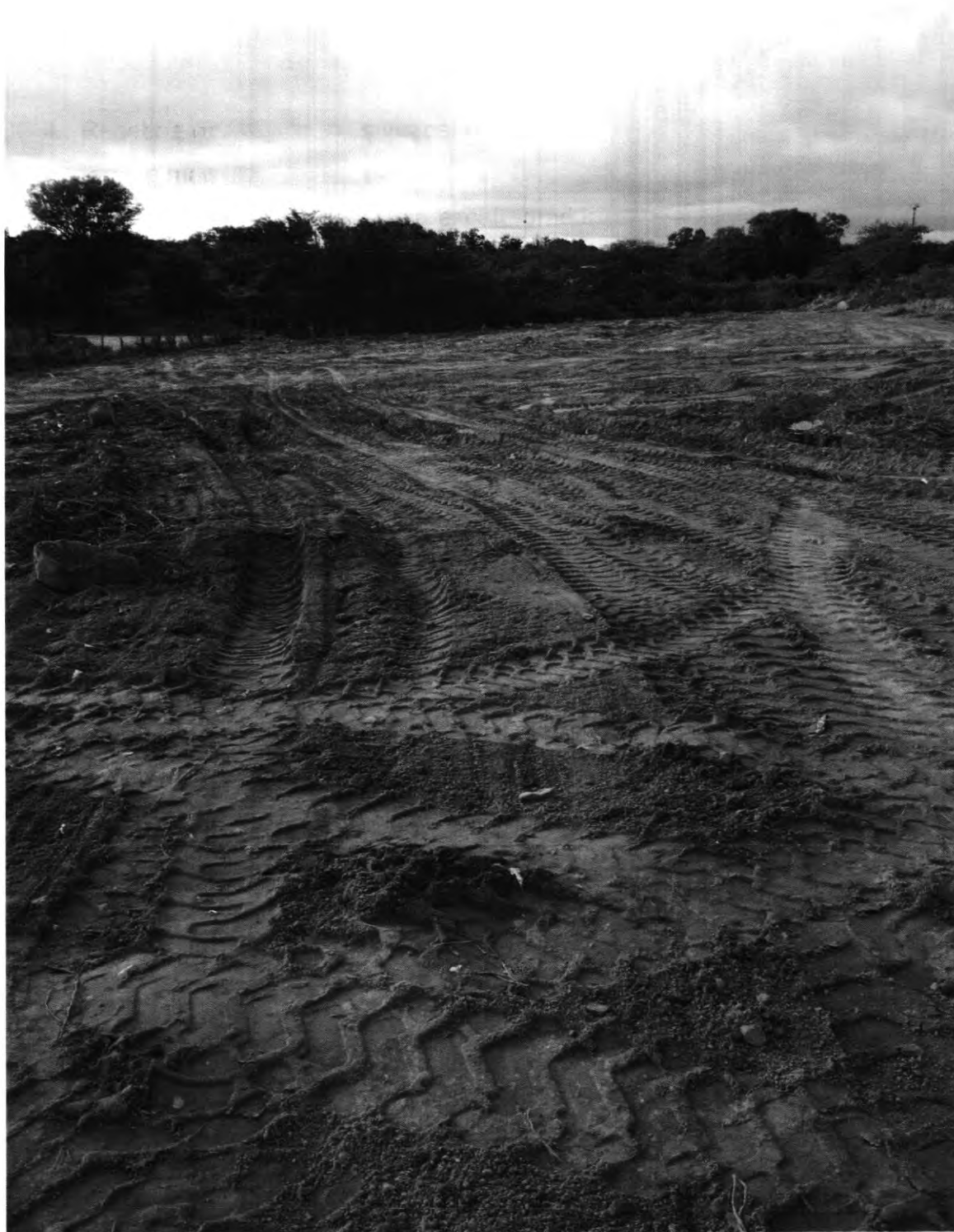
Figura 02 - Local de execução
