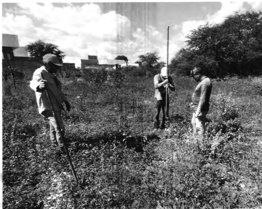
Figura 07 - Início de execução dos furos
